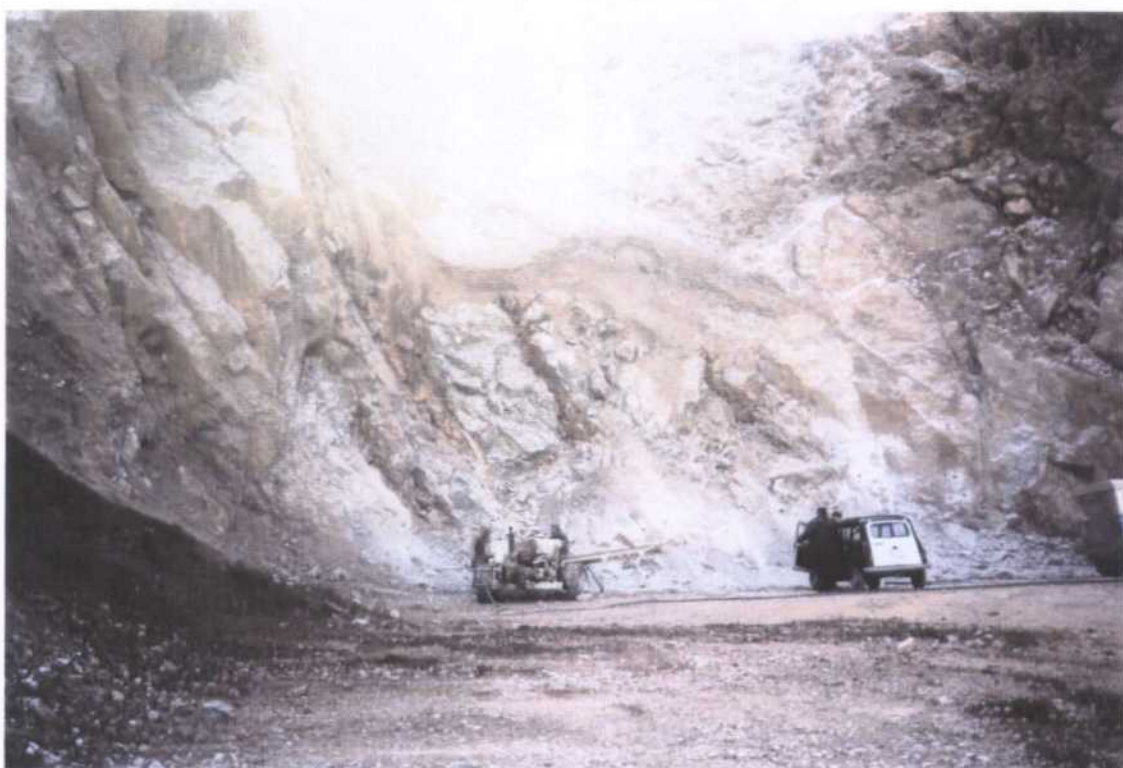
Terminando de perforar zapateras
